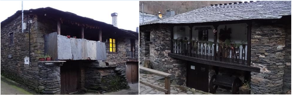
Fig. 7. Arquitectura tradicional baseada na técnica da “pedra seca” de A Seara.
